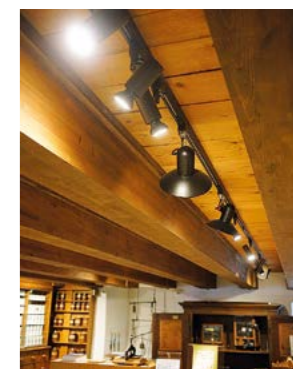
Deckenstrahler mit hohem Energieverbrauch im Apothekenmuseum Hofgeismar
