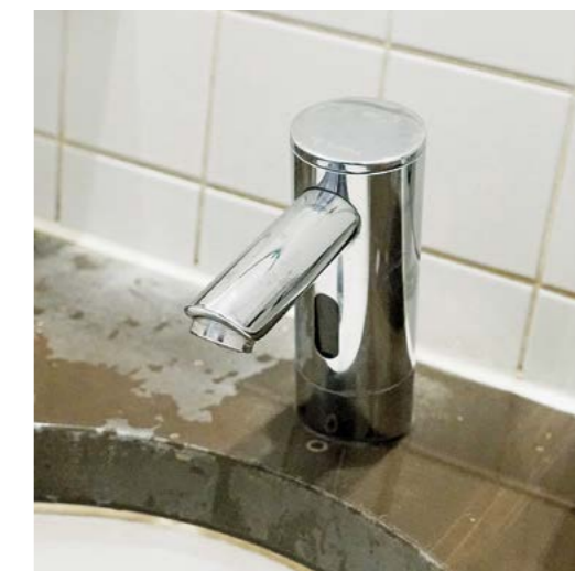
Wasserhahn-Armatur mit Infrarotsensor im Mathematikum, Gießen
